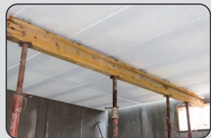
Plaats de houten balk bovenop de schorenrij tegen de afstandsringen, zonder deze te forceren.
