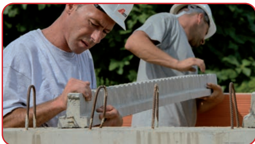
De balkjes plaatsen.
