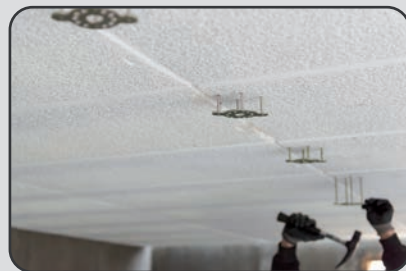
Druk de afstandsringen in tot juist tegen de balkjes.
