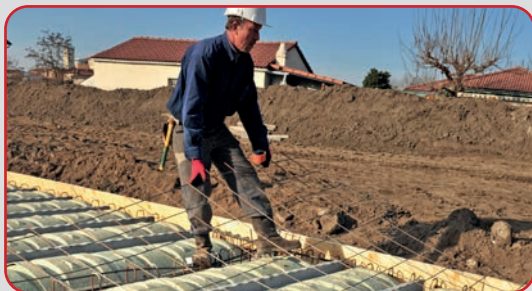
Leg de netwapening over de volledige oppervlakte van de draagvloer.
